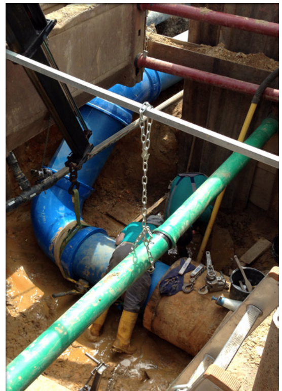
Arbeiten an Wasserrohren
